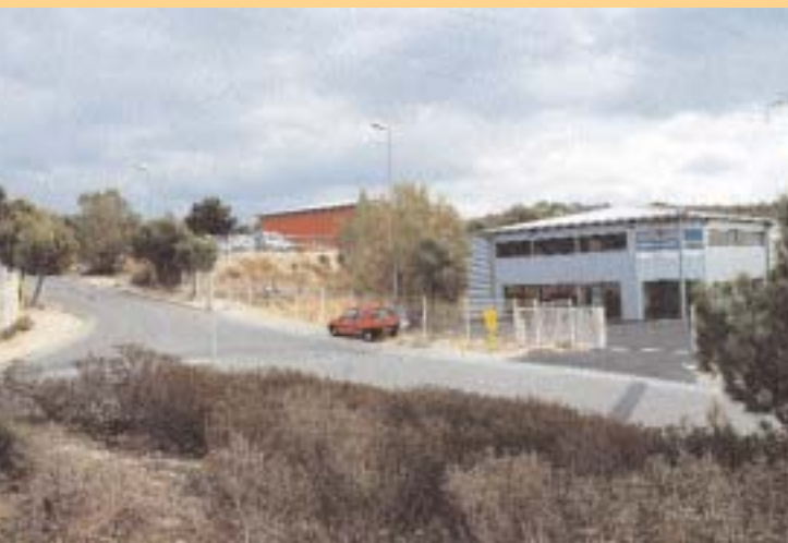
La zone Industrielle Ecopolis Martigues-Sud est gérée par un syndicat mixte (60% ville de Martigues et 40% CCIMP) pour lequel la Semivim est opérateur.
